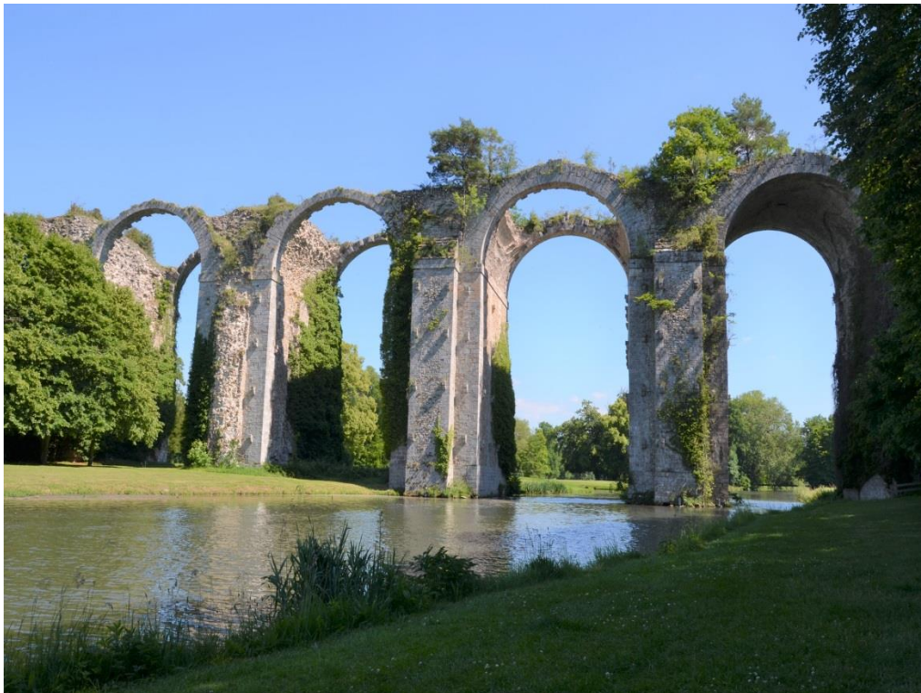
L'aqueduc ruiné de Maintenon et la rivière Eure dans le parc du château de Maintenon. © F. Bétard
